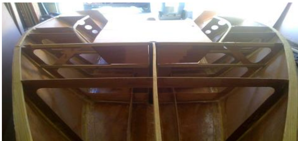
Показан установленный привальный брус, готовый для установки палубы
