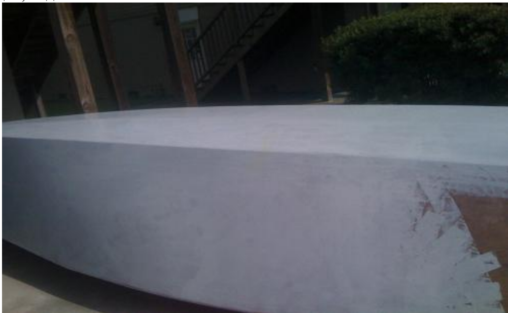
Первый из многих заканчивающих слоев дна корпуса 36
