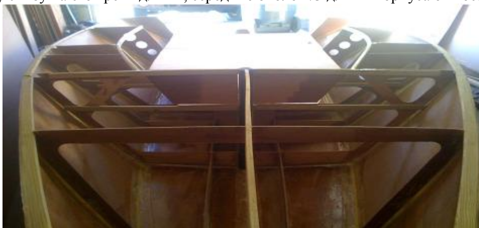
Шпангоуты установлены, замазаны и заклеены. Показан установленный внутренний привальный брус.
